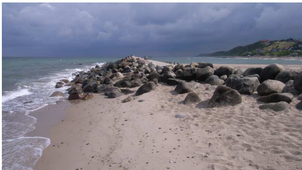
Figur 5-10 Bølgebryderen ved Tisvilde
