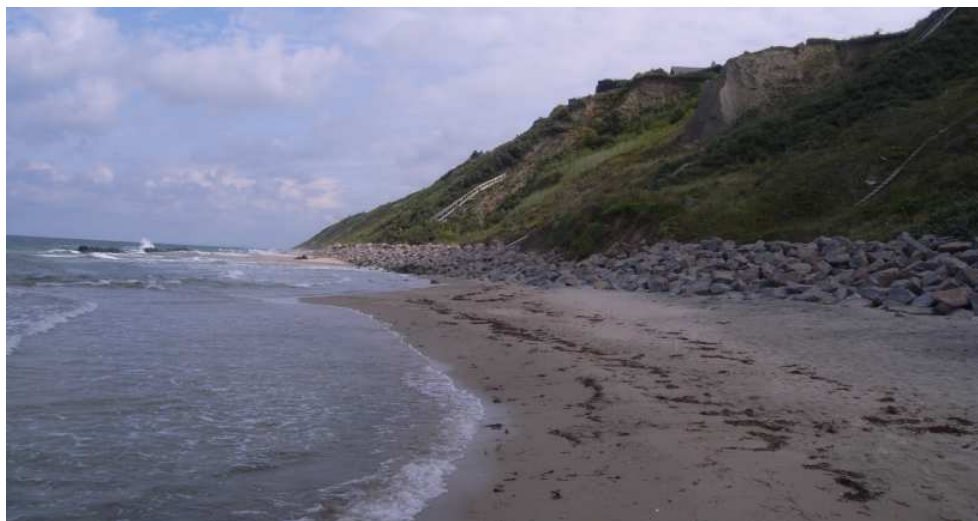
Figur 5-18 Kraftig skråningsbeskyttelse med fremskreden erosion af stranden ved Violvej
