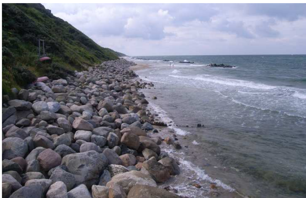
Figur 5-19 Kraftig skråningsbeskyttelse ved Kystvej, hvor stranden er forsvundet
