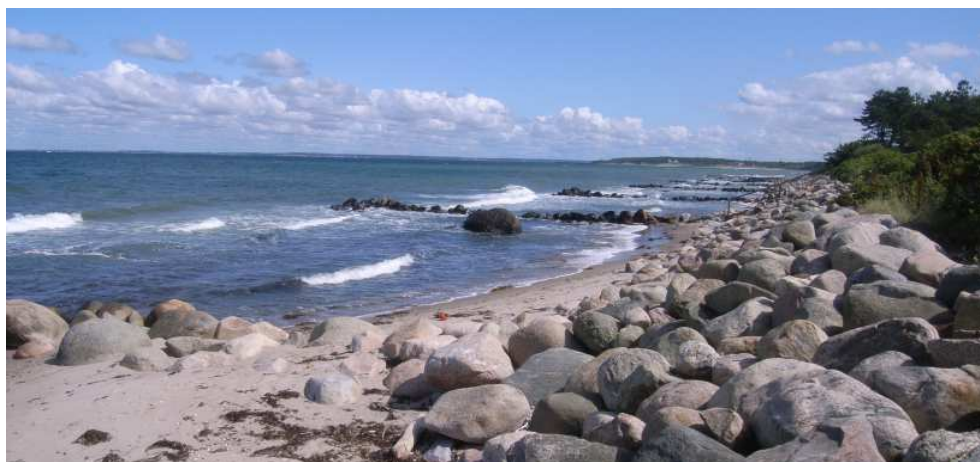
Figur 5-72 Små stenhøfder og skråningsbeskyttelse ved Villingebæk Hage
