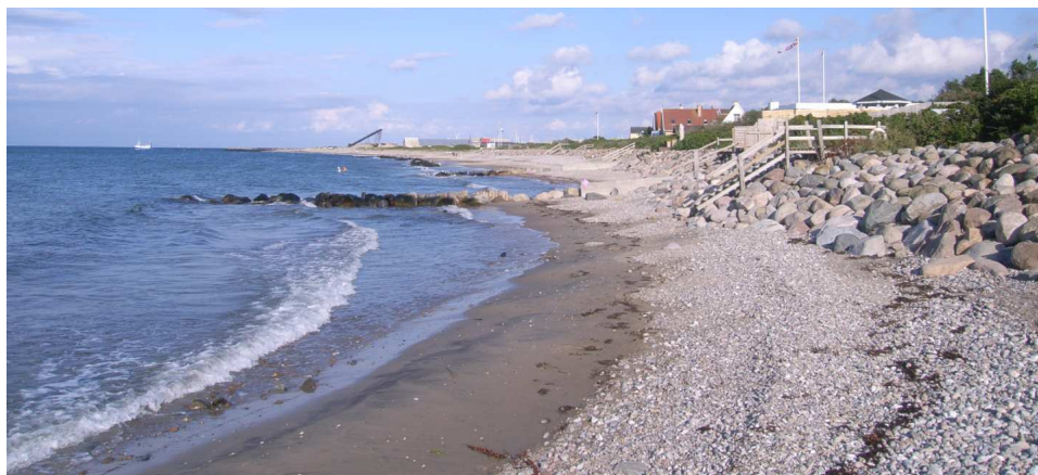
Figur 5-52 Kysten øst for stenflakket ved Børstrup Hage er beskyttet af små høfder og kraftige skråningsbeskyttelser
