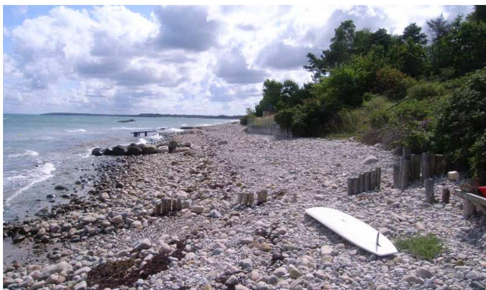
Figur 5-64 Små nedslidte træhøfder og ralstrand ved Jacobslystvej
