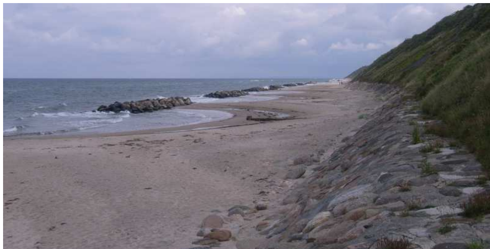
Figur 5-16 Velfungerende bølgebryderfelt ved Nordre Strandvej
