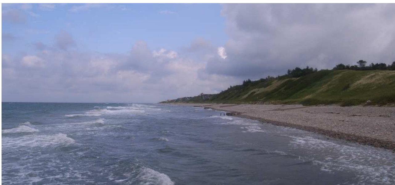
Figur 5-27 Bred rullestensstrandvold med nedslidte høfder ved Strandbjerggård
