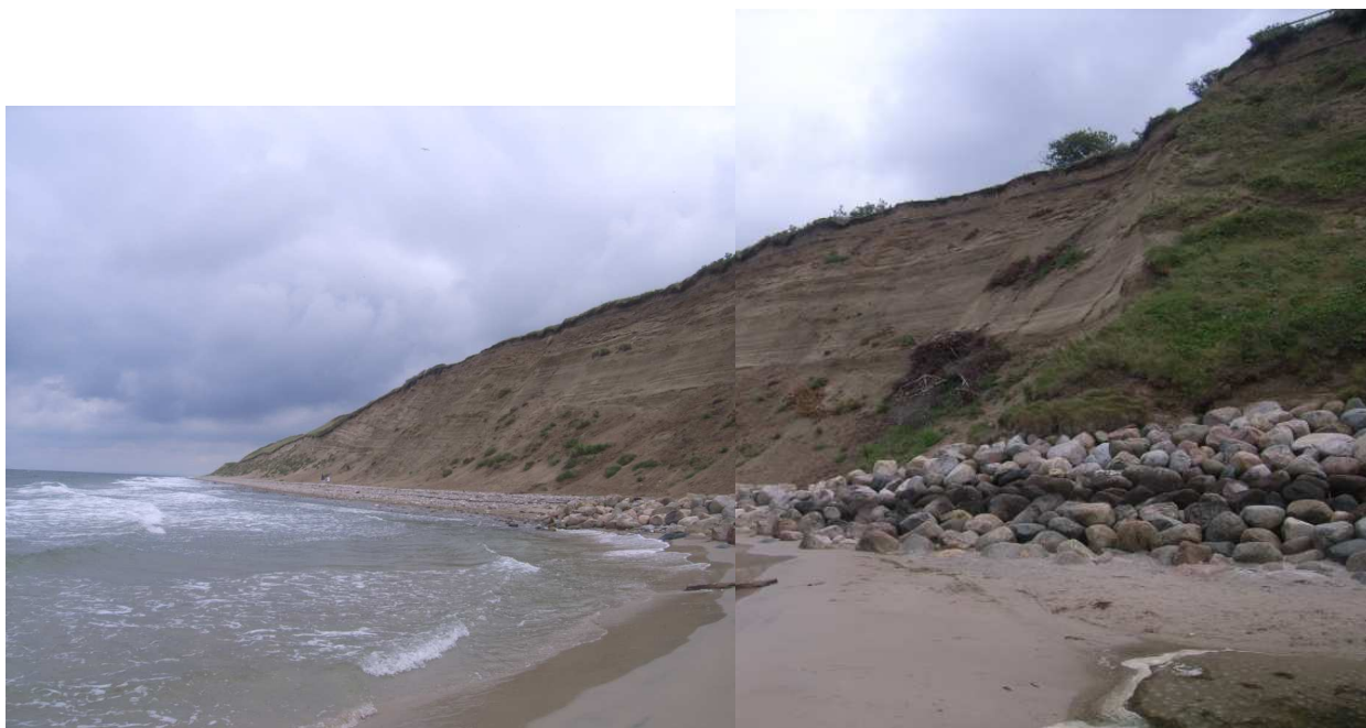
Figur 5-23 Fremskreden læsideerosion langs Vincentstien øst for bølgebryderne.
