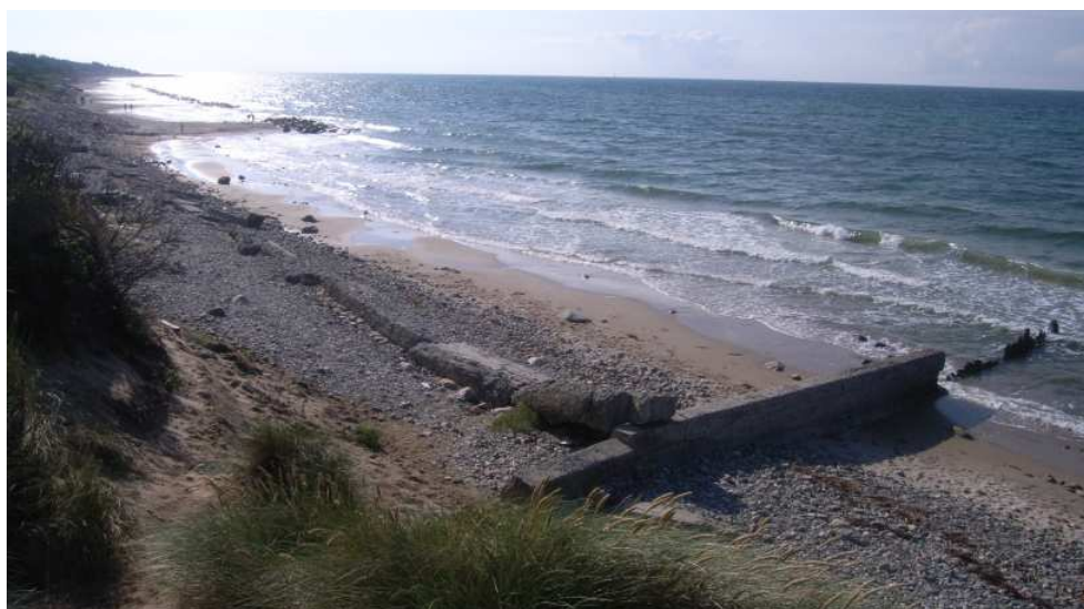
Figur 5-47 Smal strand og nedslidt kystbeskyttelse øst for bølgebryderne ved Feriebyen
