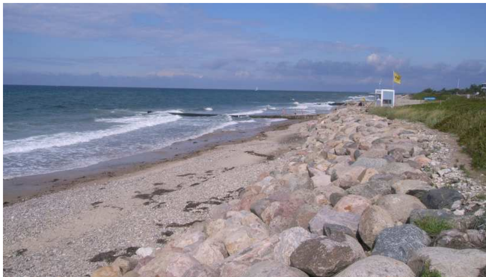
Figur 5-35 Stor ny fremskudt skråningsbeskyttelse ved Rågeleje Strandpark
