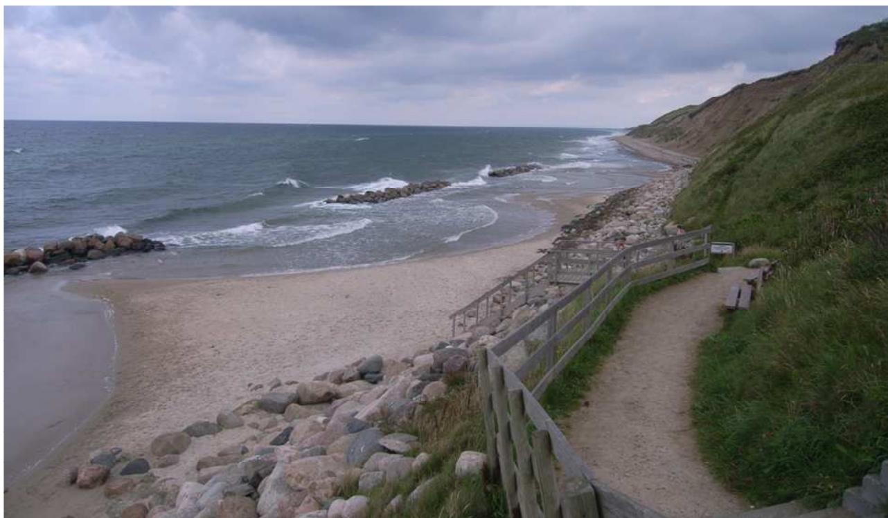
Figur 5-22 Adgangsvej til stranden ved Markvænget. Kysten er beskyttet af både kraftig skråningsbeskyttelse og bølgebrydere, men stranden er næsten forsvundet
