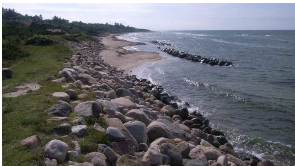
Figur 5-42 Voldsom skråningsbeskyttelse ved Strandbakkevej
