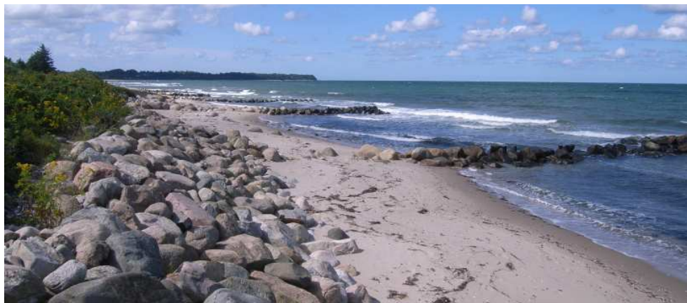
Figur 5-71 Små stenhøfder og skråningsbeskyttelse med smal sandstrand ved Villingebæk Hage
