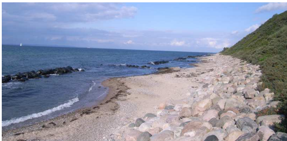
Figur 5-50 Smal stenstrand beskyttet af små bølgebrydere og skråningsbeskyttelse ved Gilbjergstien
