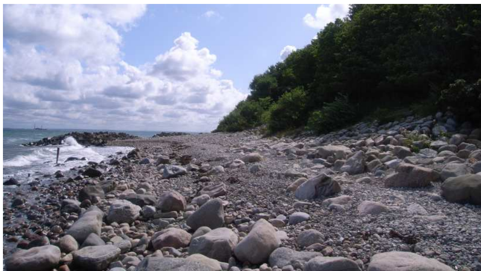
Figur 5-61 Bølgebrydere og skråningsbeskyttelse ved Nakkehoved Fyr
