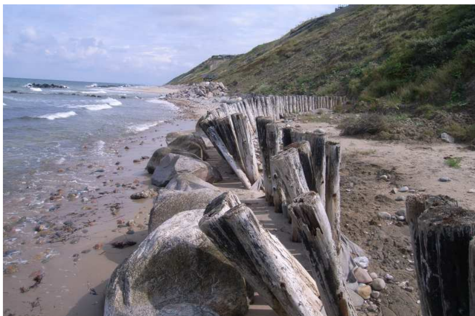
Figur 5-17 Nedslidt og uvirksom skråningsbeskyttelse ved Kaprifolievej
