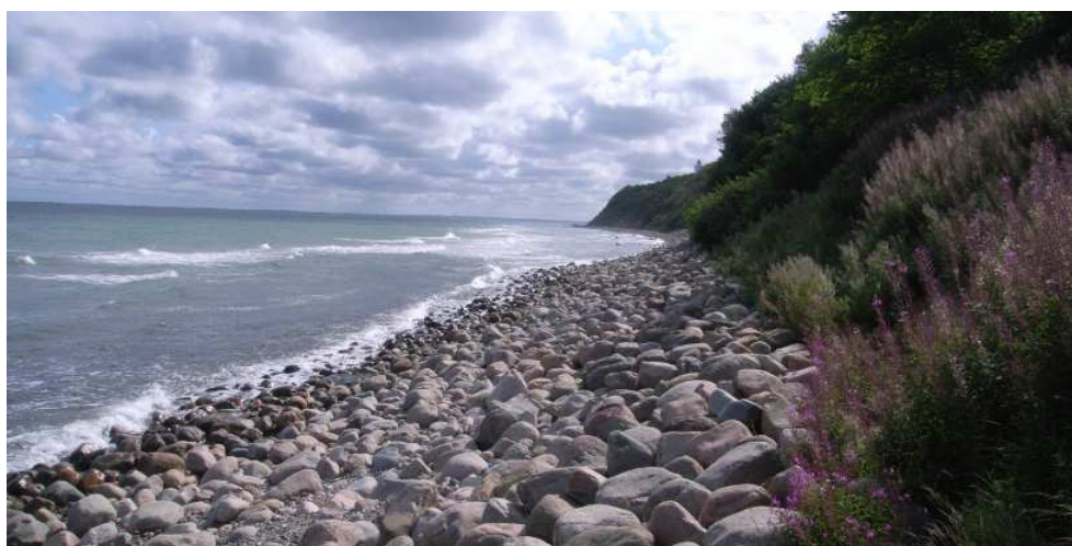
Figur 5-59 Kraftig skråningsbeskyttelse uden strand øst for Strandbakkerne
