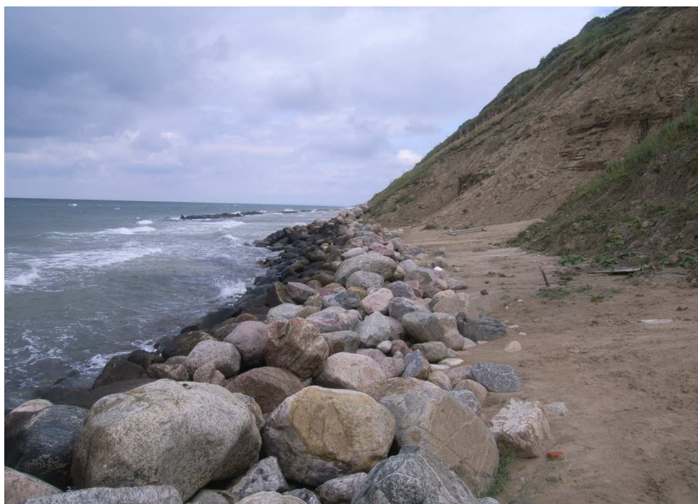
Figur 5-21 Stranden er eroderet bort og skråningen er under kraftig erosion på trods af kraftig skråningsbeskyttelse
