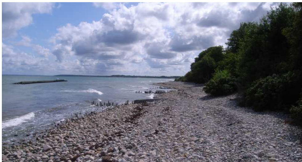
Figur 5-65 Små nedslidte træhøfder og ralstrand samt den store bølgebryder ved Munkerup Gård
