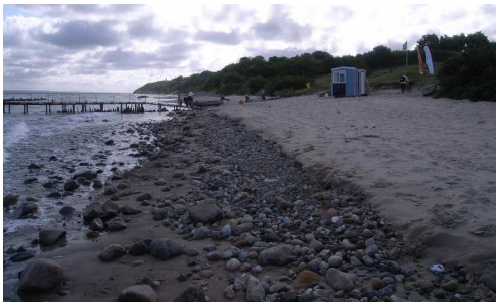
Figur 5-58 Et tyndt lag sandfodring dækker midt på sommeren stenstranden ved Strandbakkerne
