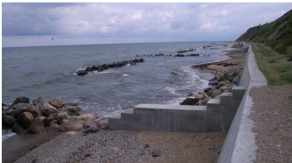
Figur 5-13 Stor skråningssikring i beton, hvor stranden er forsvundet øst for Tisvilde
