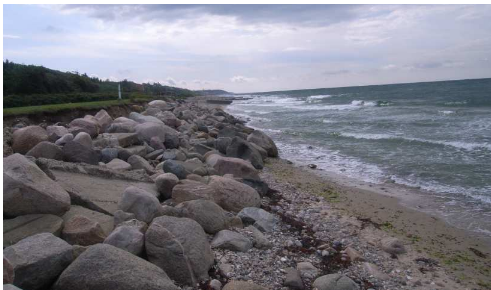
Figur 5-36 Stor fremskudt skråningsbeskyttelse ved Trillingerne
