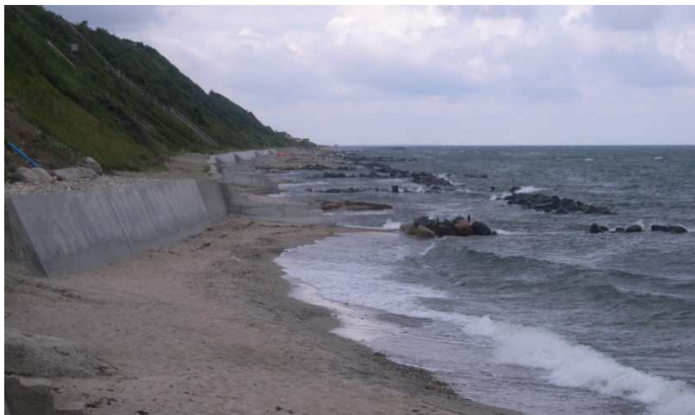
Figur 5-14 Stor skråningssikring i beton, hvor stranden er forsvundet øst for Tisvilde
