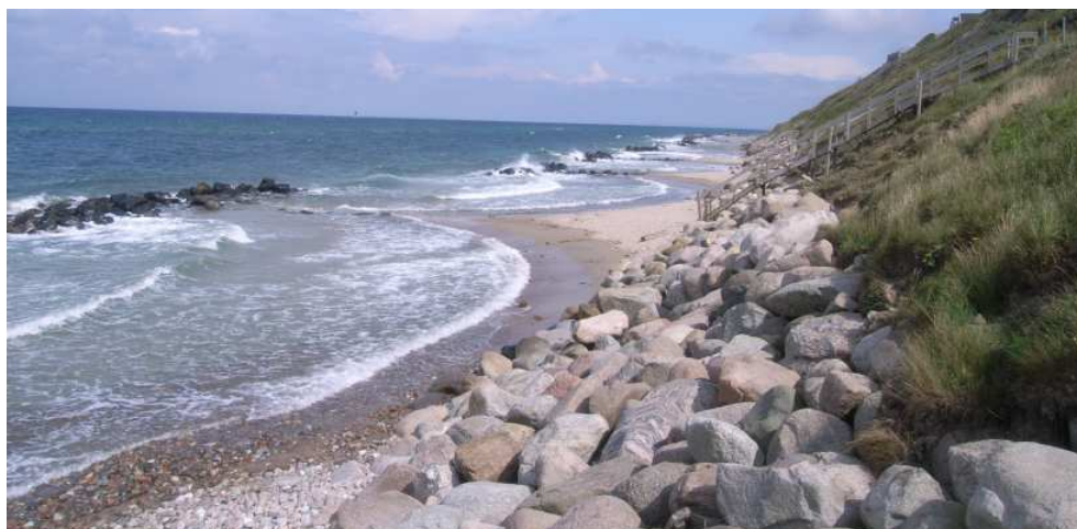
Figur 5-20 Kraftig skråningsbeskyttelse ved Kystvej (Mågevej), hvor stranden er forsvundet
