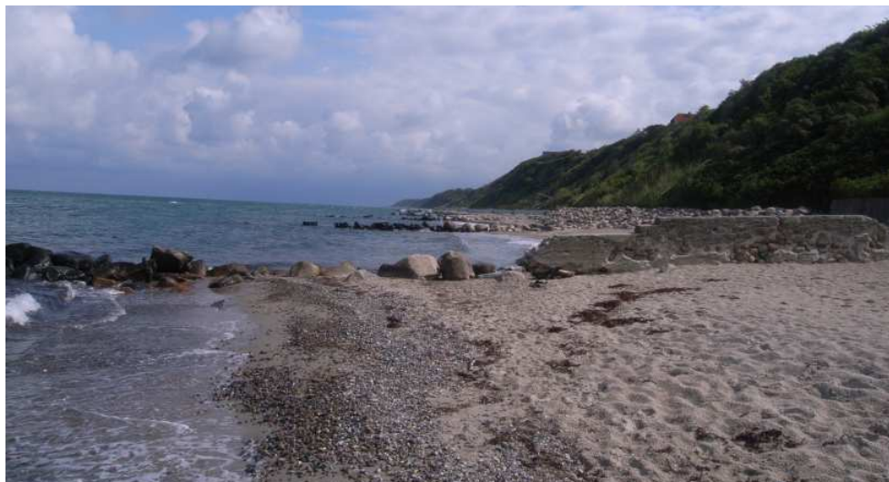
Figur 5-12 Nedslidte høfder ved Tisvilde
